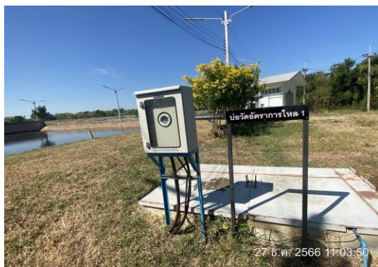
รูปที่ 13 ติดตั้ง Flow Meter
