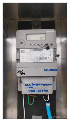
รูปที่ 7 มิเตอร์ตรวจวัดไฟฟ้าที่ระบบบำบัดน้ำเสียส่วนกลาง
